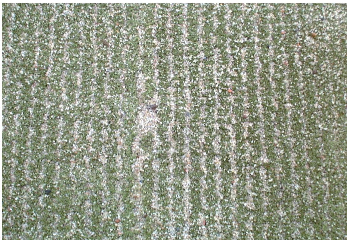
Abb. 130: Abgenutzter Kunststoffrasen: Die Tuftgassen sind an den hellen Streifen zu erkennen.
