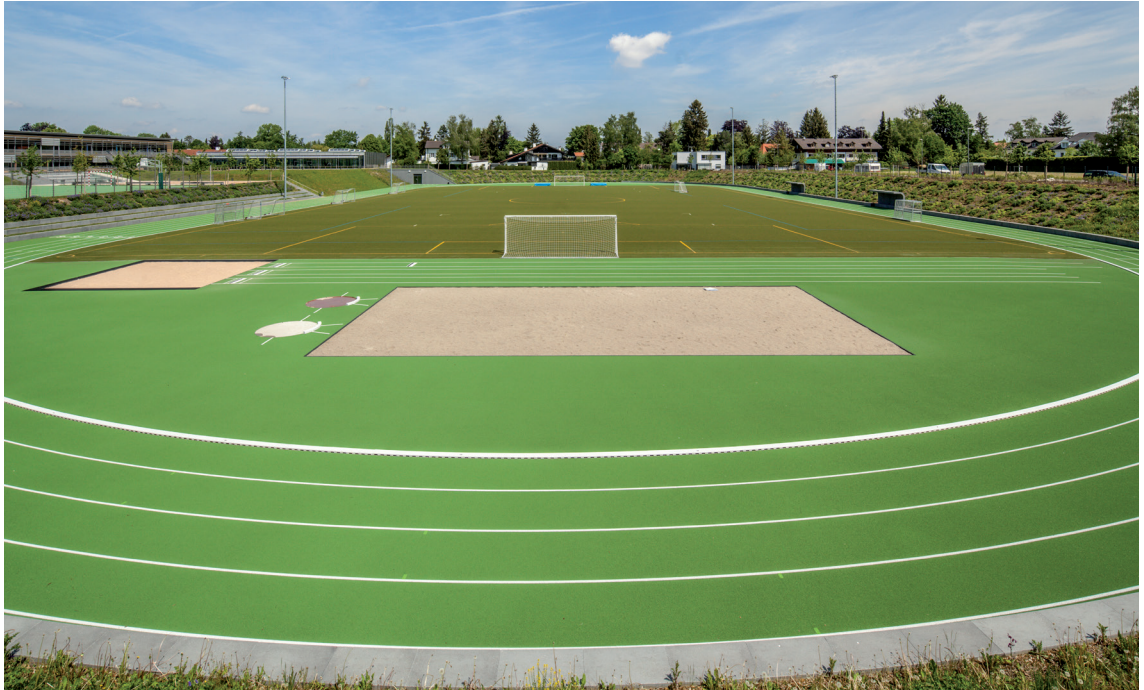
Abb. 111: Rundlaufbahn, Strukturbeschichteter Belag Typ A
