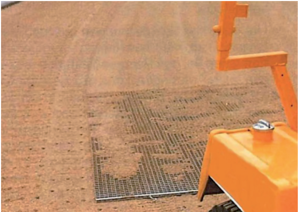
Abb. 89: Einschleppen des Stützkorns in die Lochkanäle
