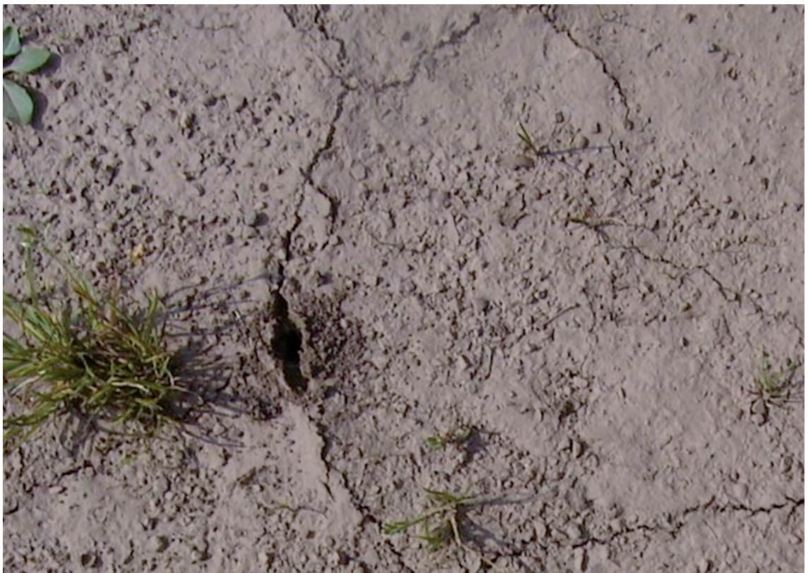
Abb. 87: Feinteilablagerungen auf einer Tennenfläche
