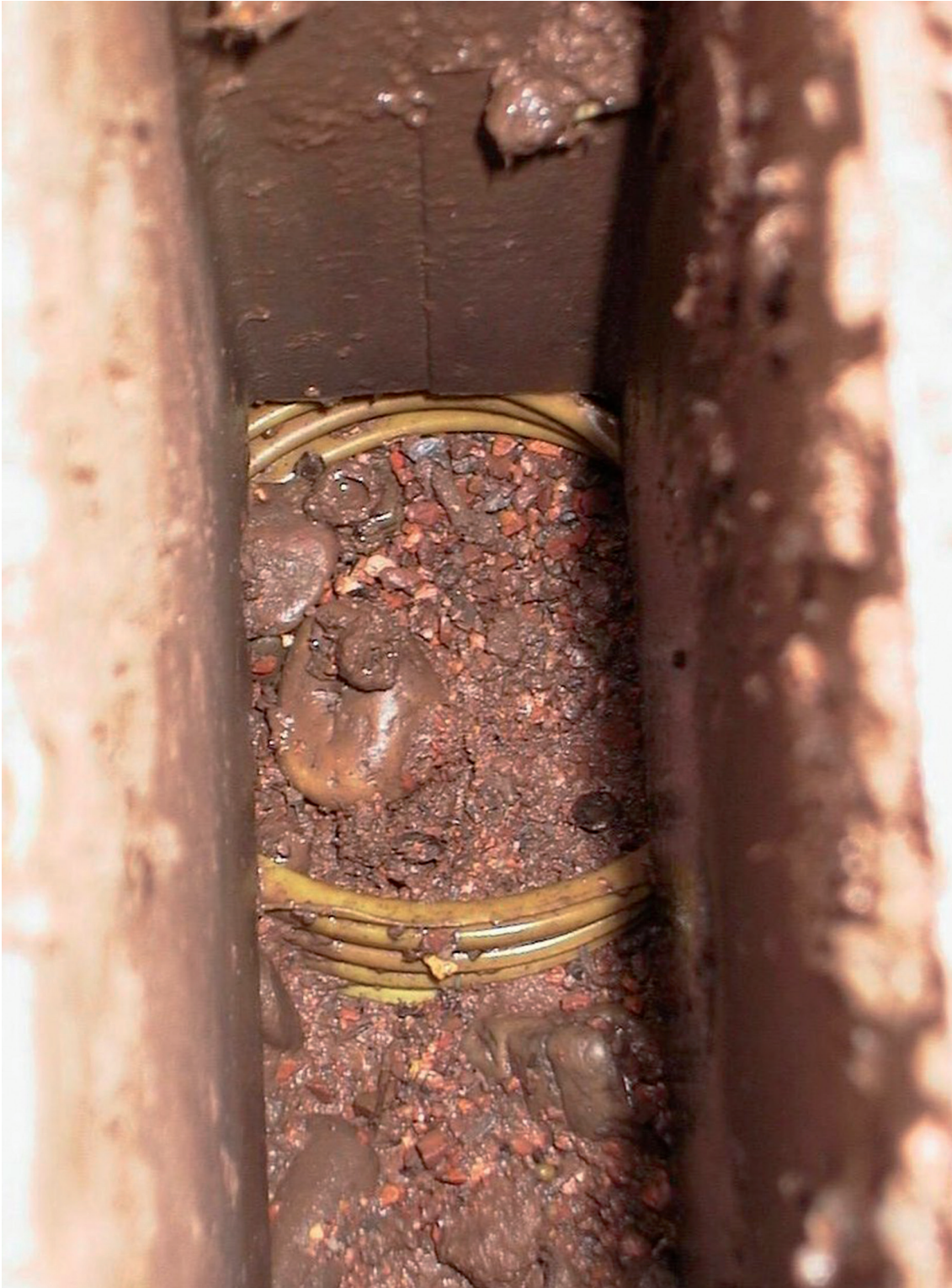
Abb. 86: Einlaufkasten mit verstopftem Dränrohr
