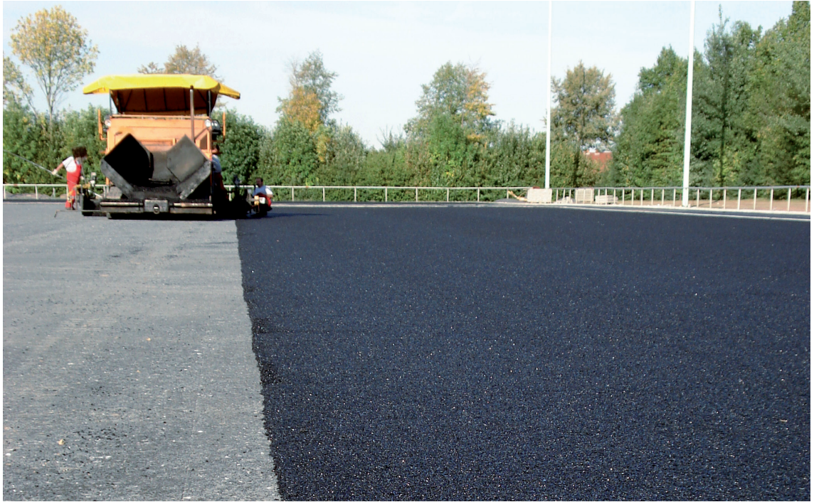
Abb. 119: Installation von elastischen Schichten
