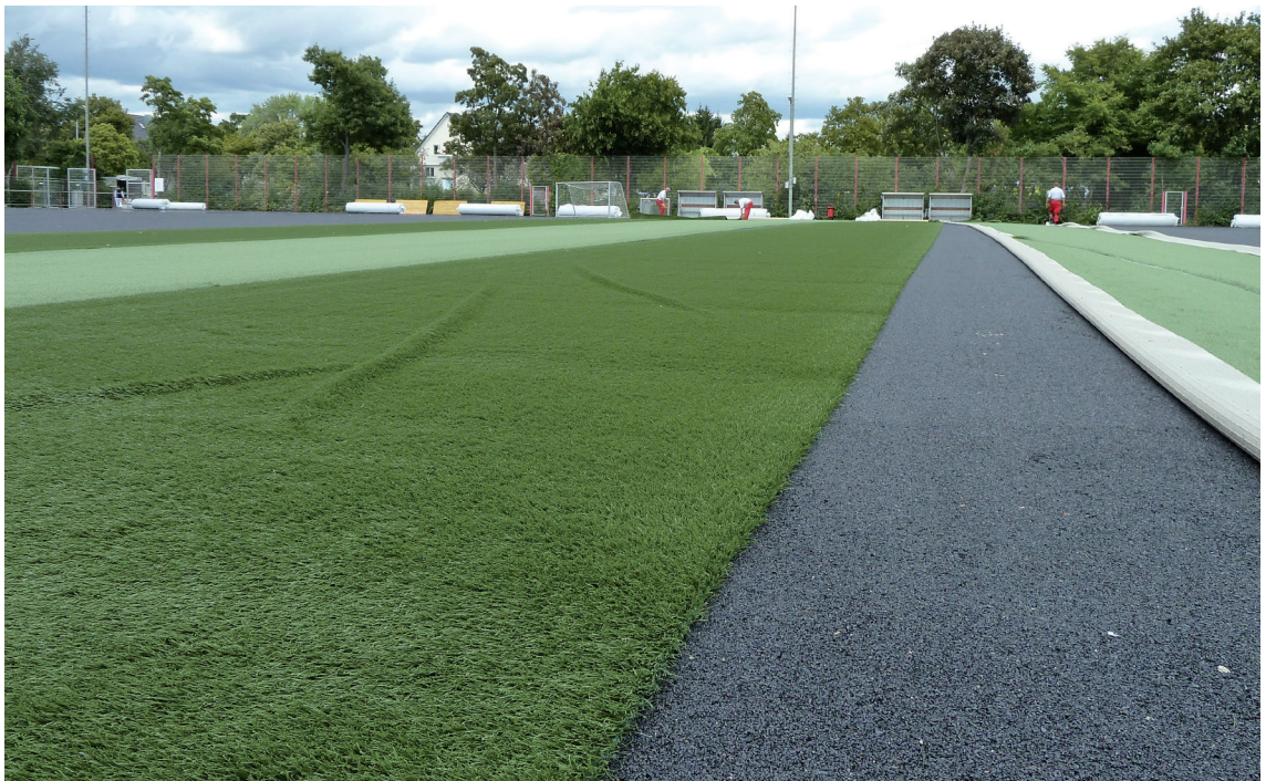
Abb. 120: Verlegung von Rasenbahnen
