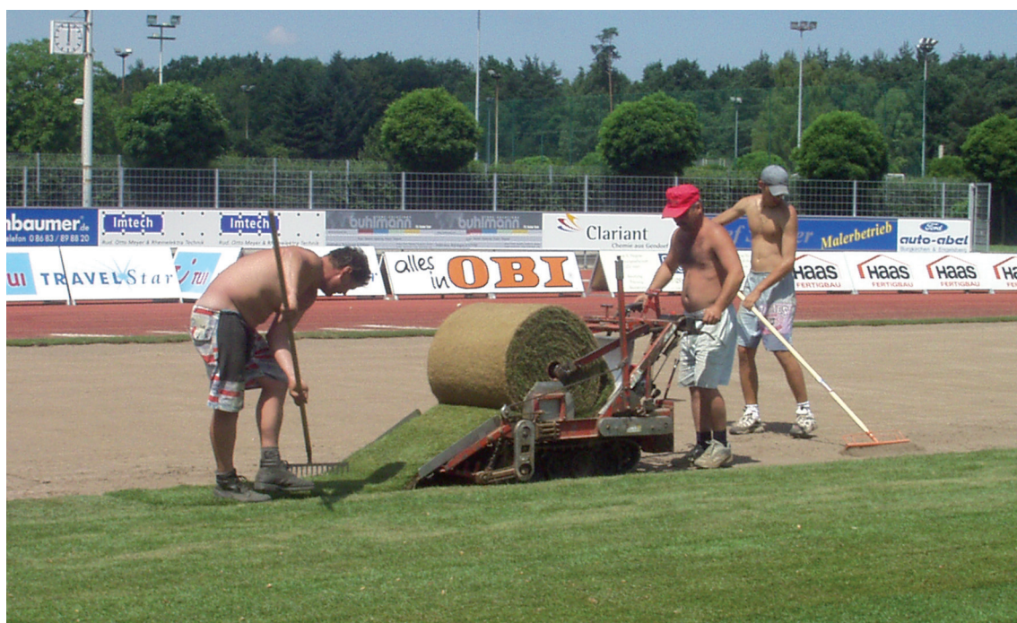
Abb. 36: Verlegen von Fertiggras, unmittelbar nach Aufrauen des Planums der Rasentragschicht
