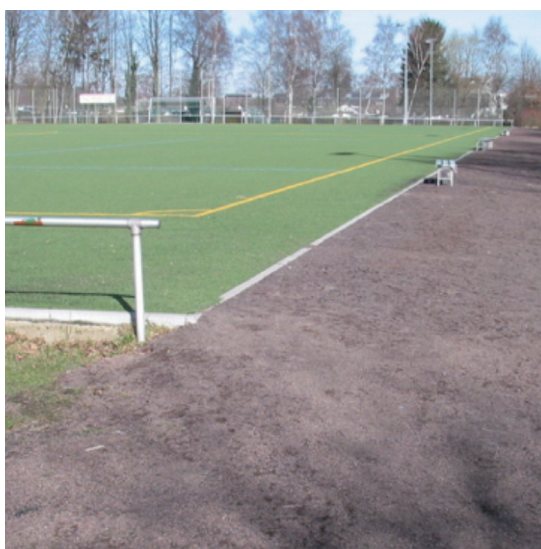
Abb. 126: Ungeeignete Belagskombination (Kunststoffrasen/Tenne)
