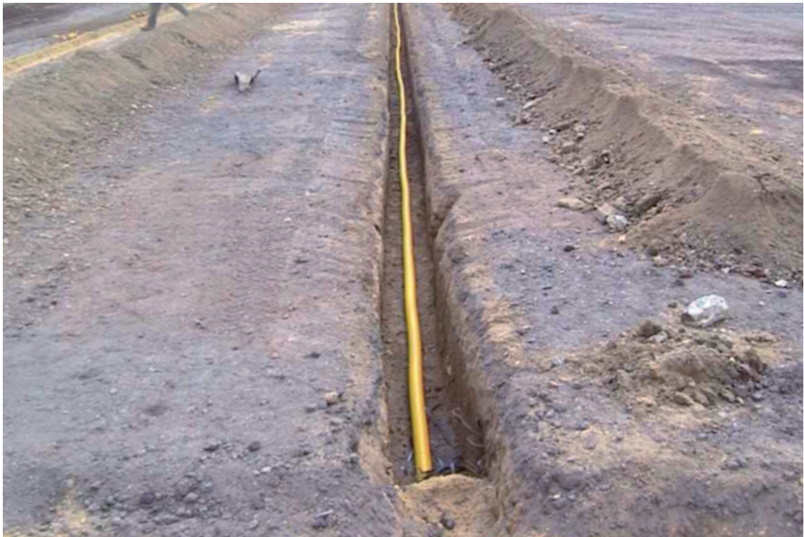
Abb. 127: Dränstrang mit Dränleitung
