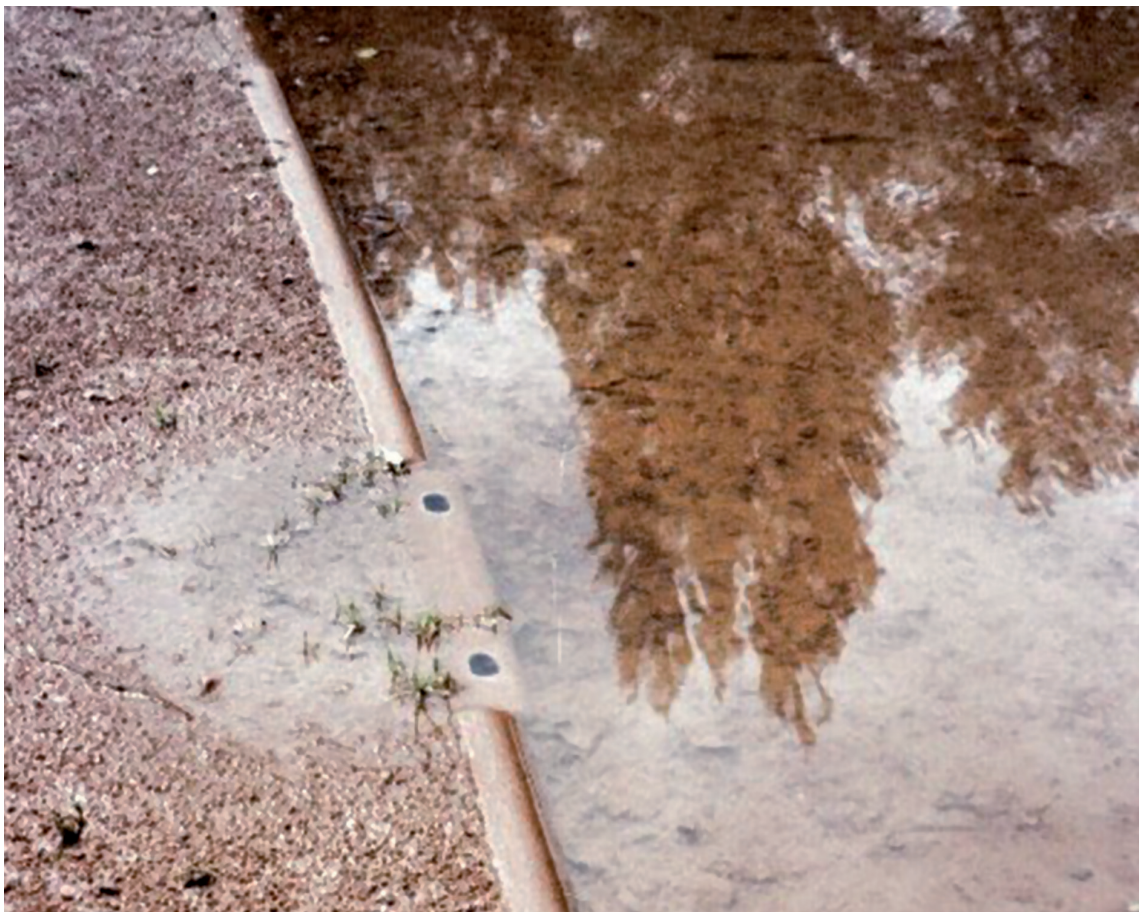
Abb. 85: Einlaufkasten steht unter Wasser, funktionsunfähig
