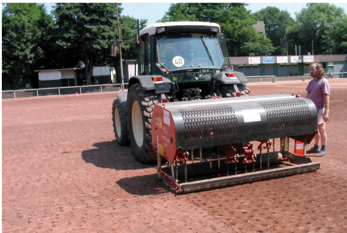
Abb. 88: Lochen eines undurchlässigen Tennenbelags und Perforationslöcher
