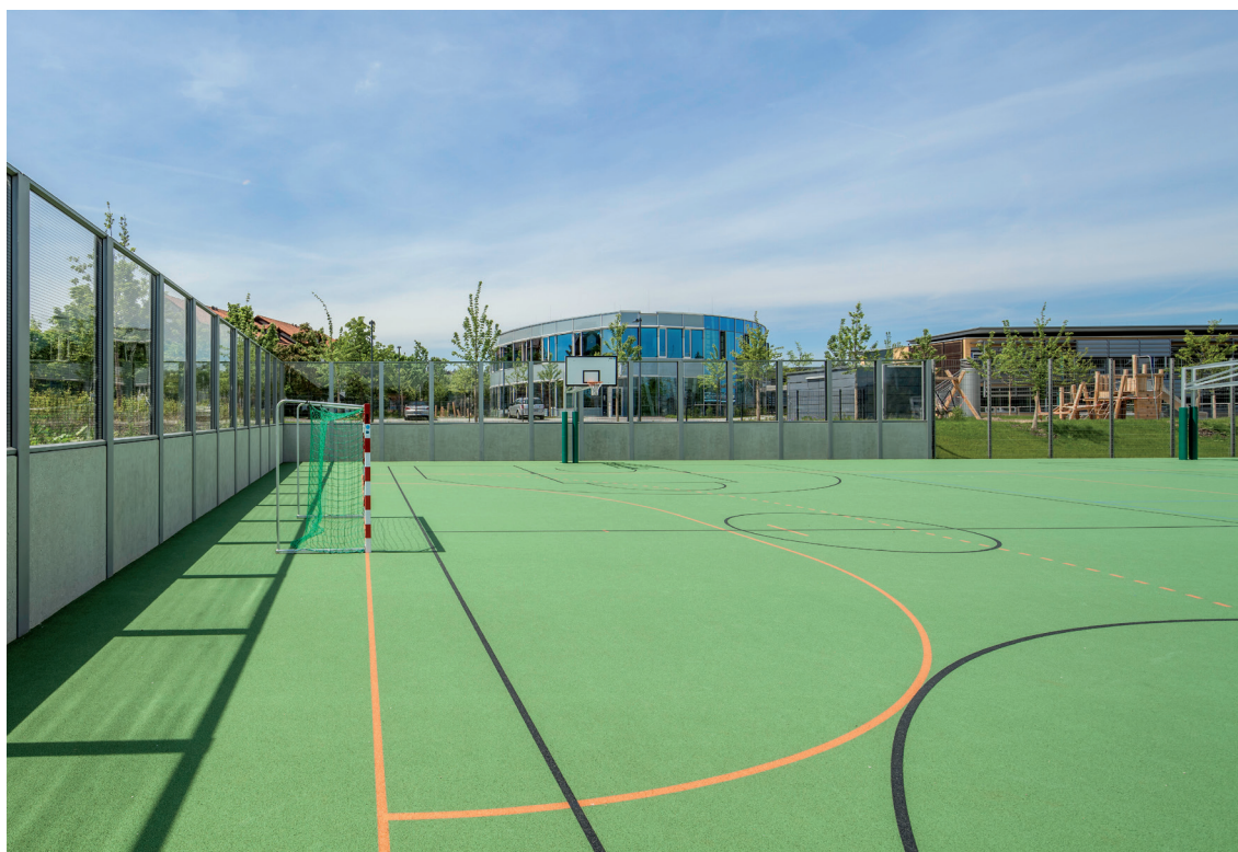
Abb. 108: Multifunktionsspielfeld, Schüttbeschichteter Belag Typ B
