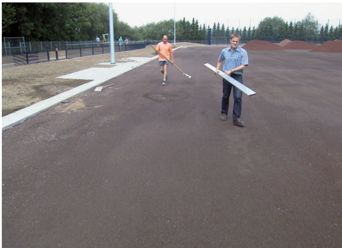
Abb. 75: Überprüfung der dynamischen Schicht vor dem Einbau des Tennenbelages
