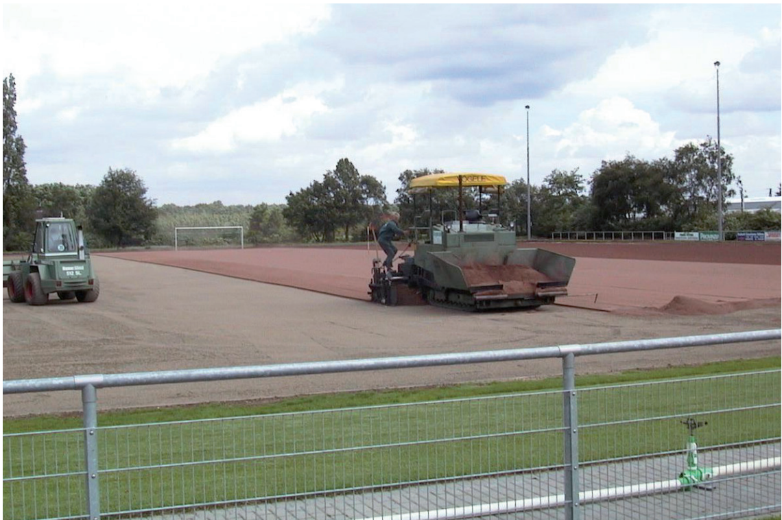
Abb. 76: Schottertragschicht während des Einbaus
