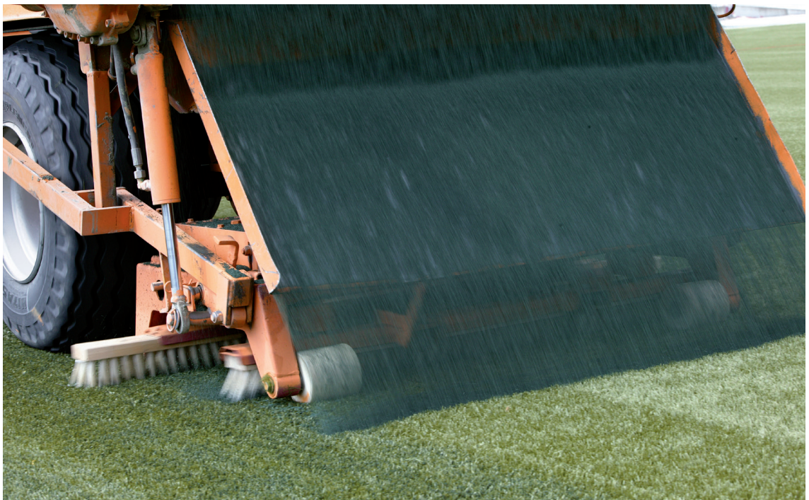
Abb. 123: Gummibefüllung
