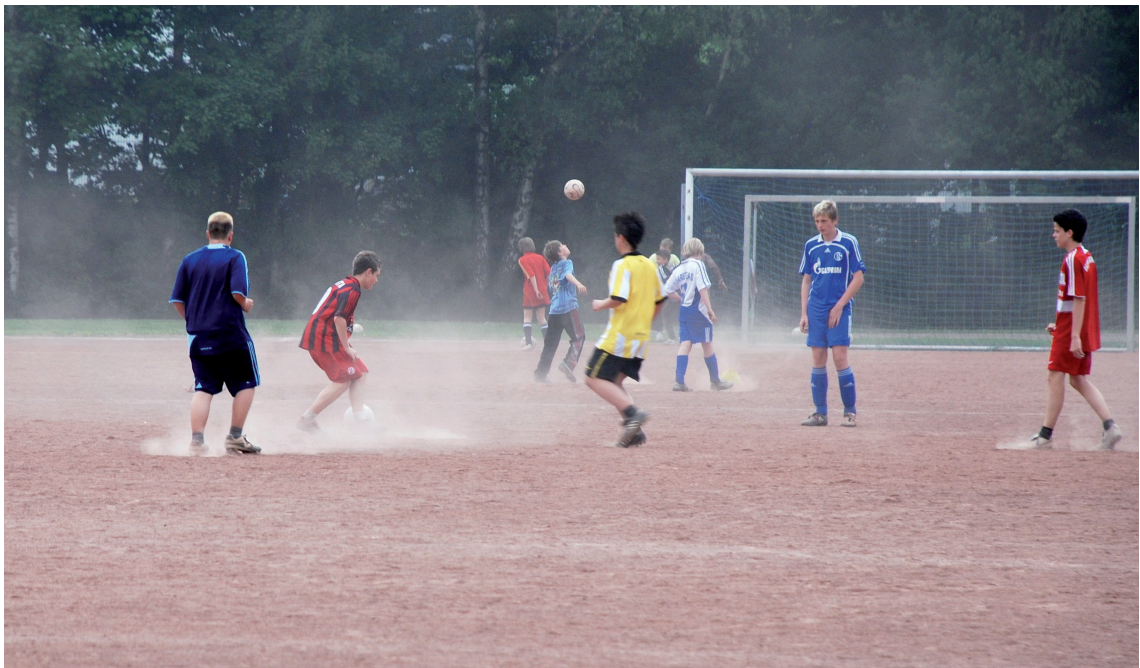
Abb. 70: Staubentwicklung durch Trockenheit und Entmischung der Deckschicht
