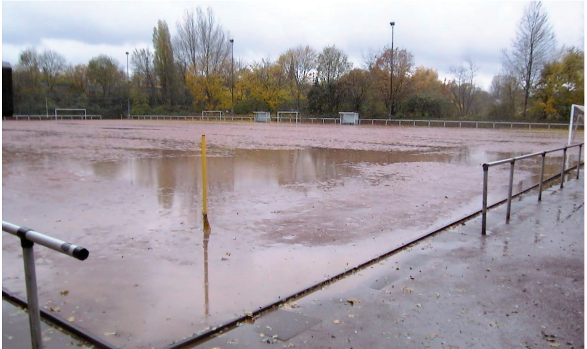
Abb. 90: Völlig unzureichende Wasserdurchlässigkeit eines Tennisbelages
