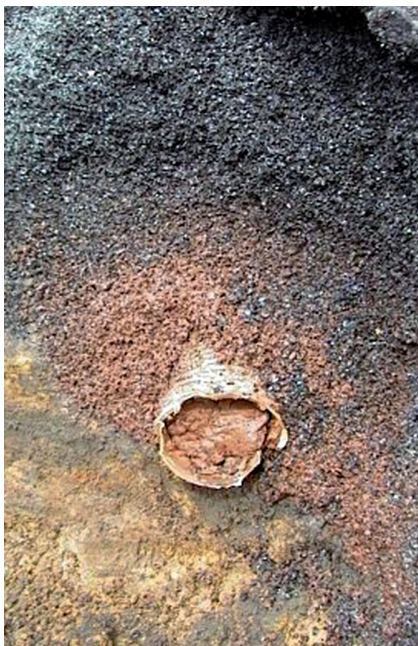
Abb. 91: Verstopftes Dränrohr mit verunreinigter Dränpackung
