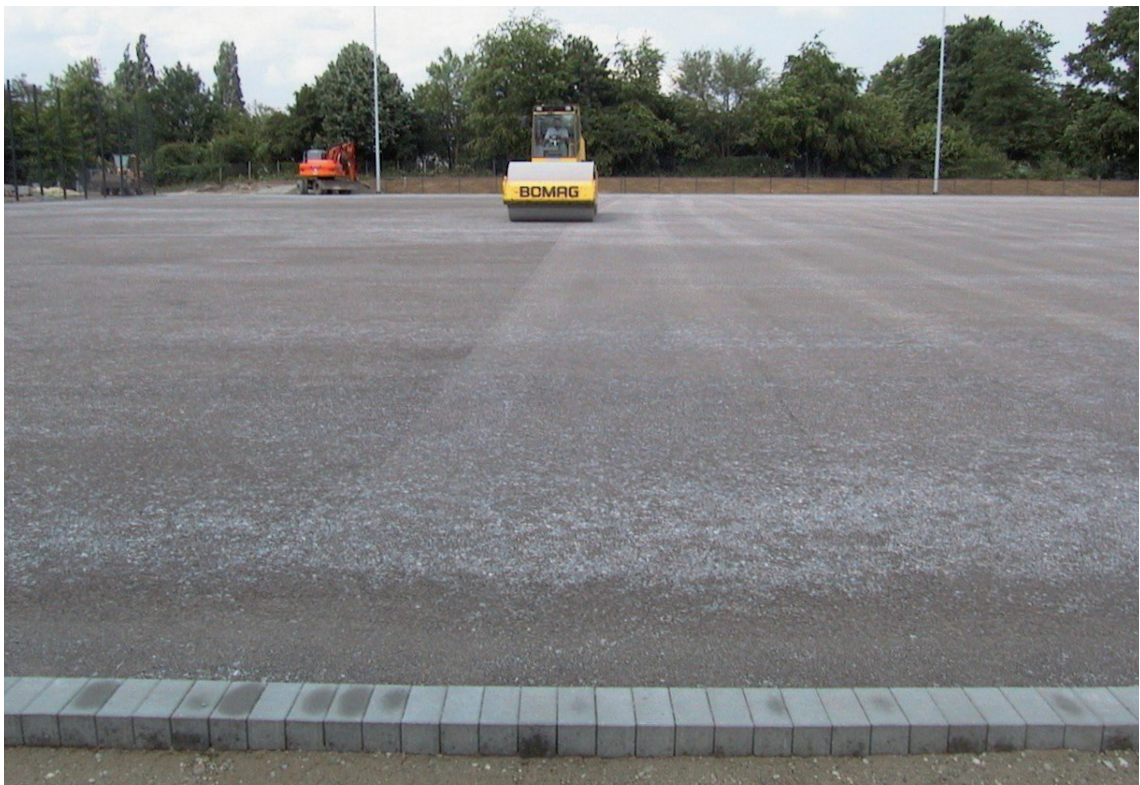
Abb. 74: Schottertragschicht während des Einbaus
