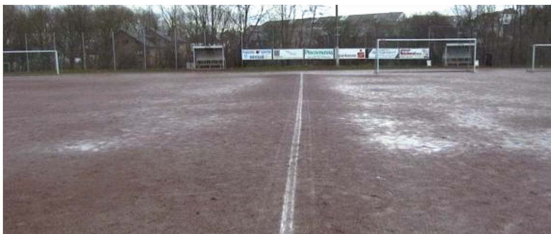
Abb. 80: Markierungslinien, erhöht
