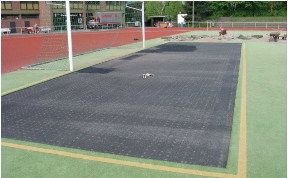
Abb. 131: Kunststoffrasen ausgeschnitten und ET-Schicht überarbeitet
