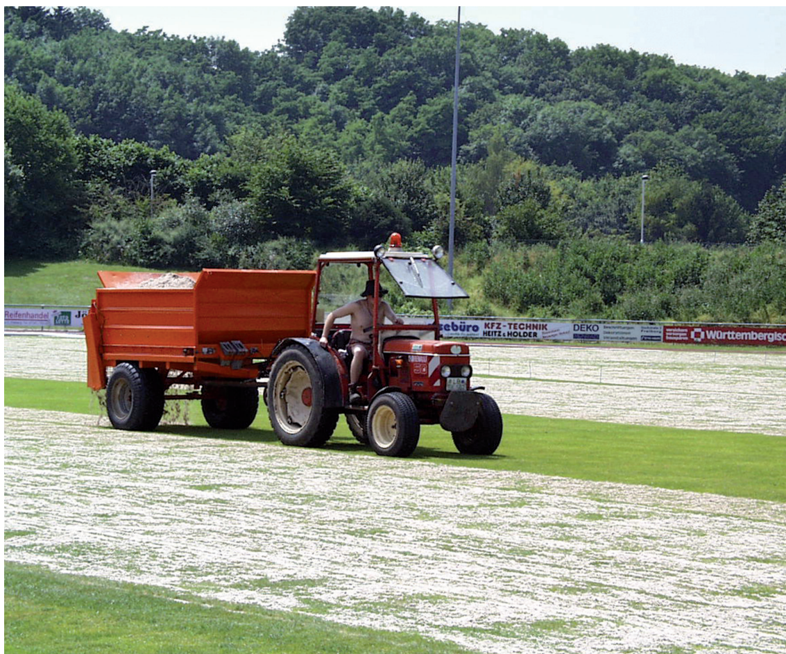
Abb. 45: Besandung einer Rasensportfläche vor dem Löffern
