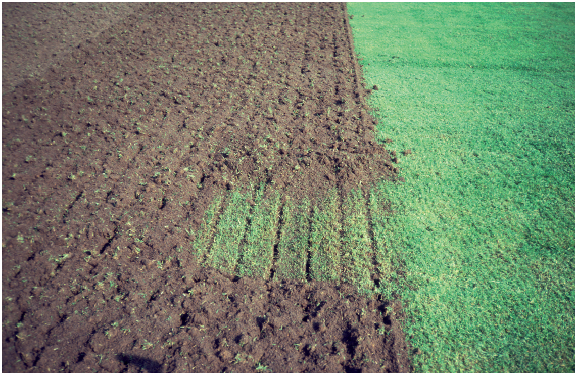
Abb. 59: Freigelegte Frässlitzte nach Bearbeitung einer Besandungsschicht. Die Frässlitzte werden durch das entstandene Gemisch aus Besandungsschicht wieder locker verfüllt.
