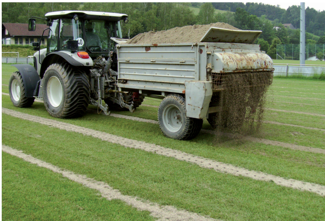
Abb. 64: Besanden zum Abschleppen der mit Dränschlitz versehenen Rasenfläche als Abschluss der Renovationsmaßnahmen
