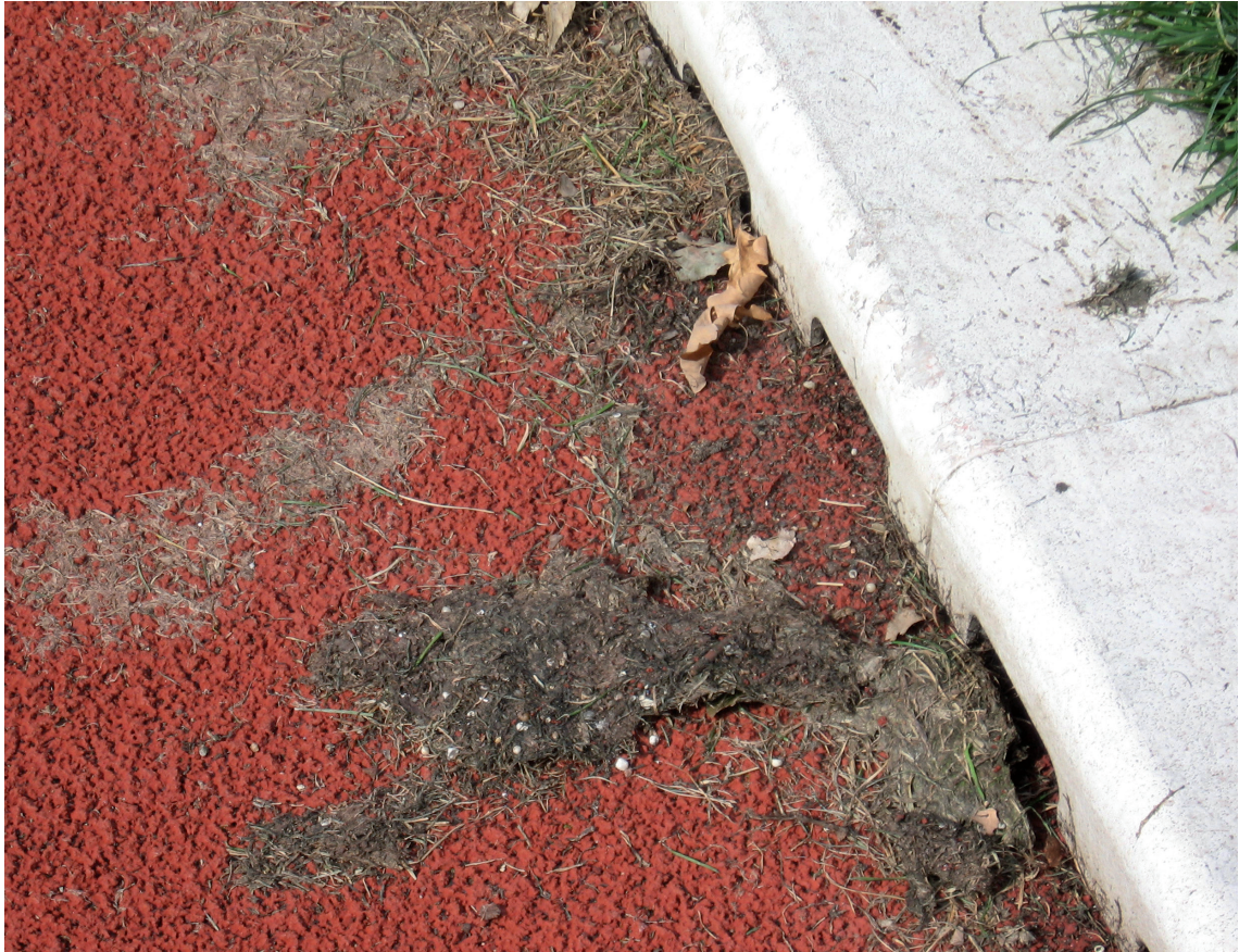
Abb. 109: Wasserabfluss durch Mähgut eingeschränkt
